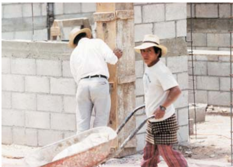
Trabajadores en obra.
